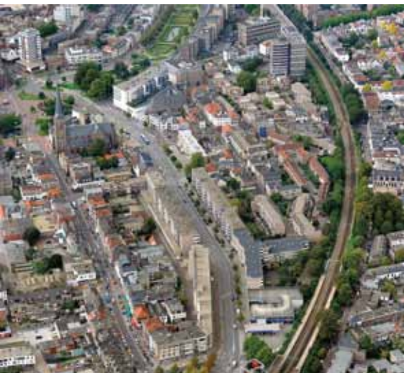
Doorbraak in de bestaande stad ten behoeve van autoverkeer. De Ing. J.P. van Muijwijkstraat moest in het verlengde van de eveneens nieuw aangelegde Looierstraat de binnenstad beter ontsluiten naar het oosten. (foto: De Gelderlander)
