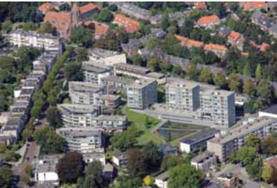
Inbreiding in een bestaande wijk. Park Sonswijk is gebouwd op de plaats van het voormalige Diaconessen ziekenhuis. (foto: De Gelderlander)
