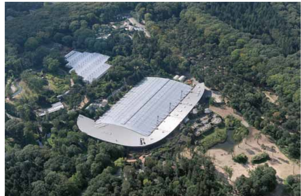
Heel bijzondere verspreide bebouwing in het groen: Burgers Zoo aan de Schelmseweg (foto: De Gelderlander)
